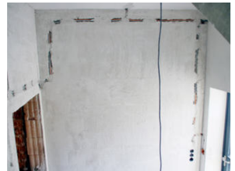
Sinnvolle Abläufe planen: Roh- und Trockenbauarbeiten wie Schlitze in der Wand müssen erledigt sein, bevor tapeziert oder gestrichen wird.
